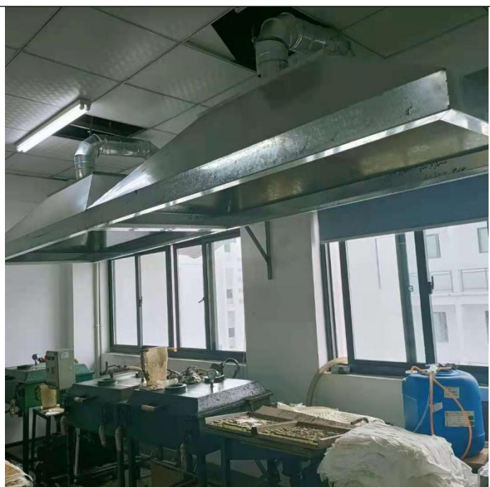
真空含浸机上方设集气罩
