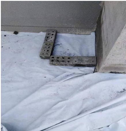
危废库防渗处理
