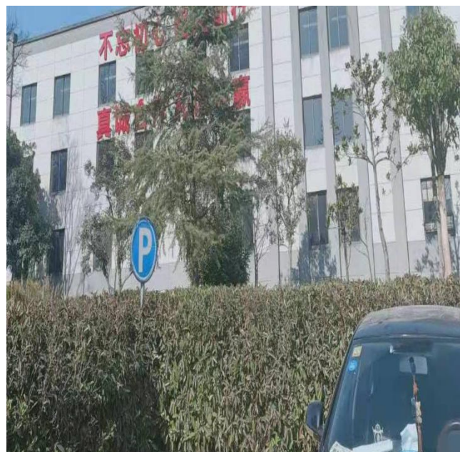
本项目新建车间
