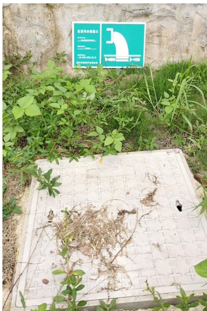
污水总排口标识牌
