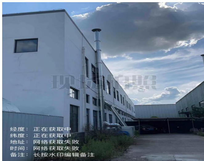
废气处理设施（二级活性炭）及 15m 高的排气筒
