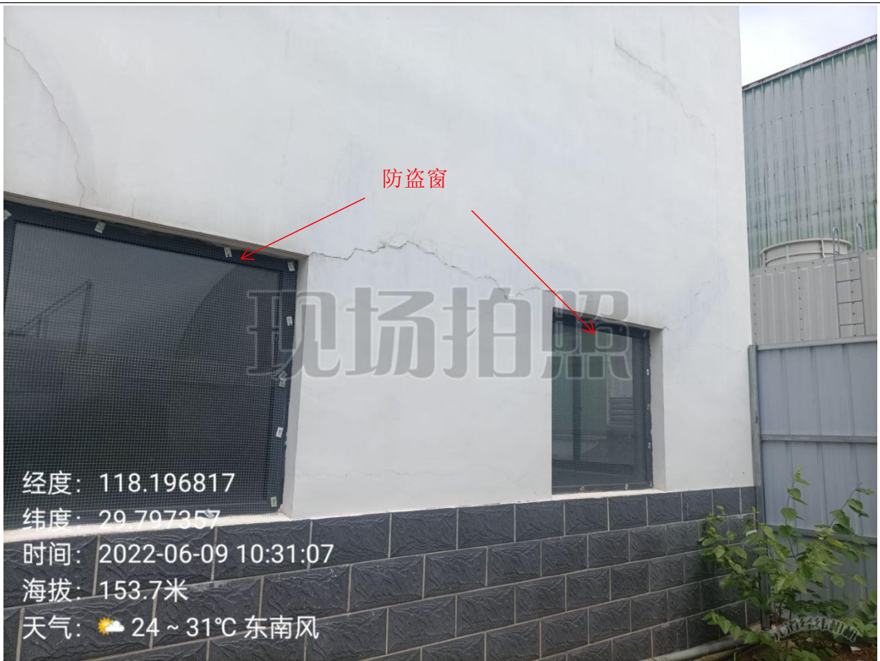
车间安装防盗窗
