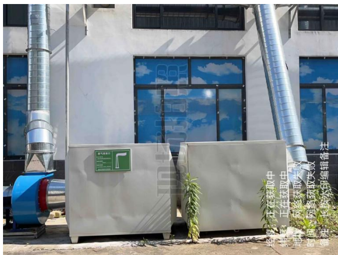
废气处理设施（二级活性炭）及 15m 高的排气筒
