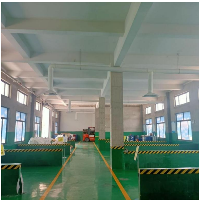
内部分区防渗
