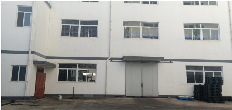
固化剂车间（作为原料仓库使用）
