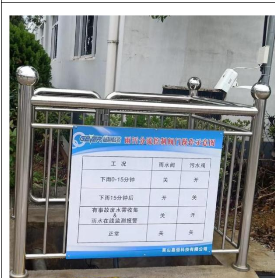
雨污分流阀操作示意图
