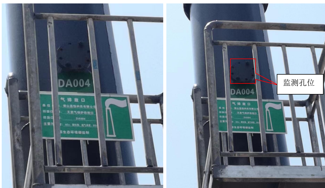
图 4.6-3 厂区 DA004 废气排放口标识牌及采样孔照片
