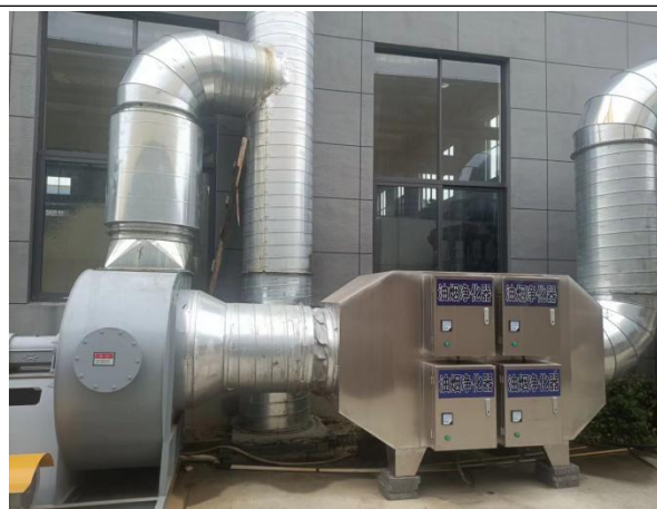
水式过滤箱+高效静电净化器+活性炭吸附装置
