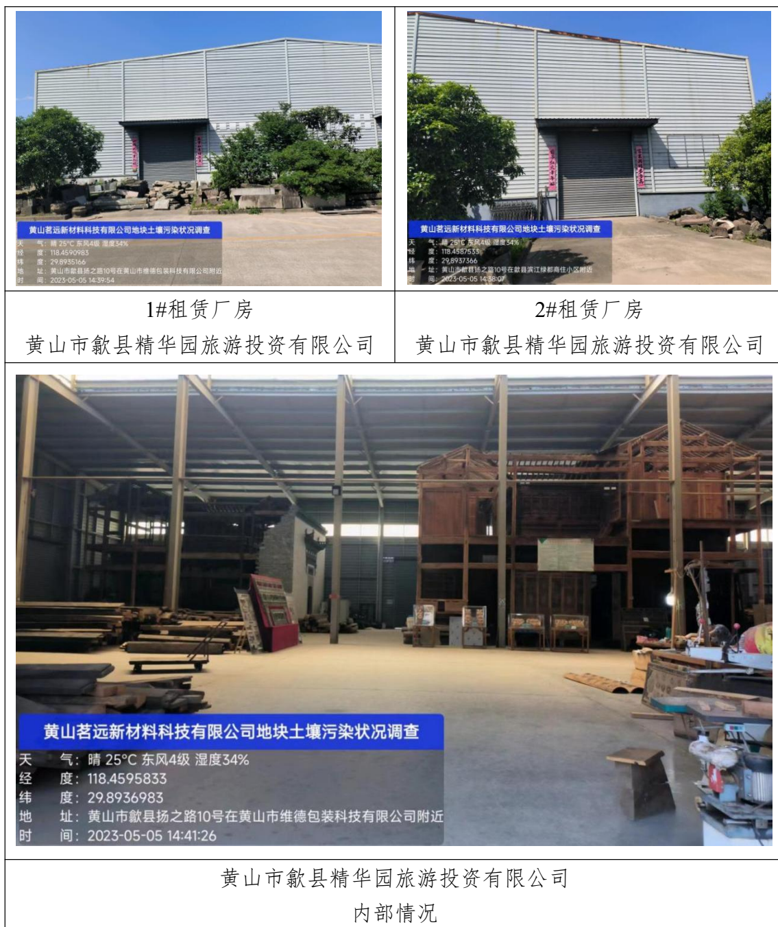
图 2.2-2 调查地块内部现场照片
