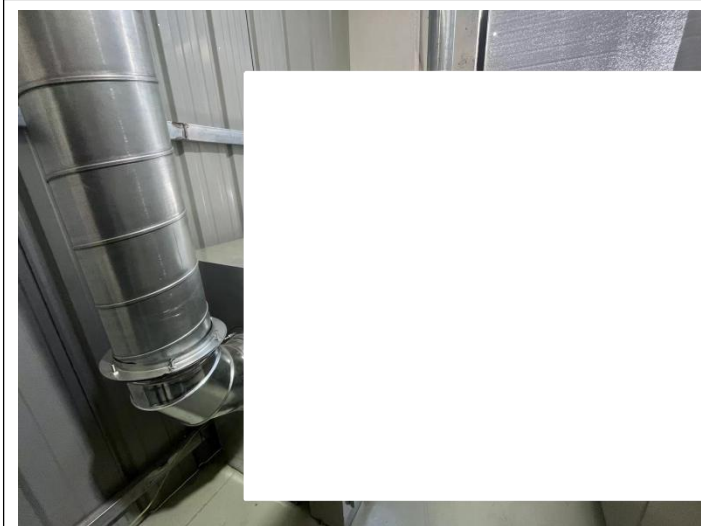
热处理废气收集及处理设备（活性炭吸附）
