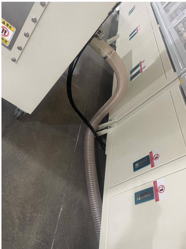
滤筒除尘器废气进口
