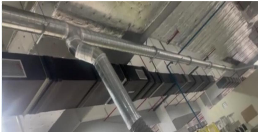
滤筒除尘器废气进口
