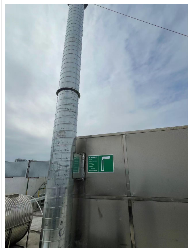
DA001 NMP 回收装置排气筒
