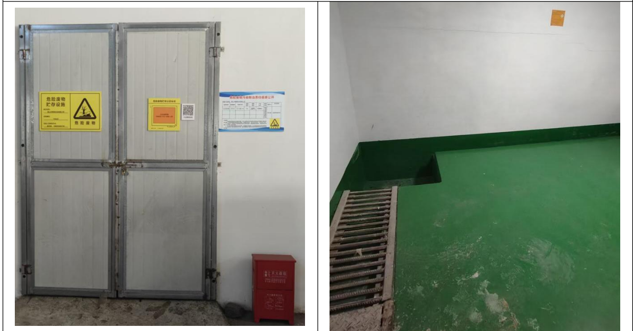
污泥暂存间 (TS002)
