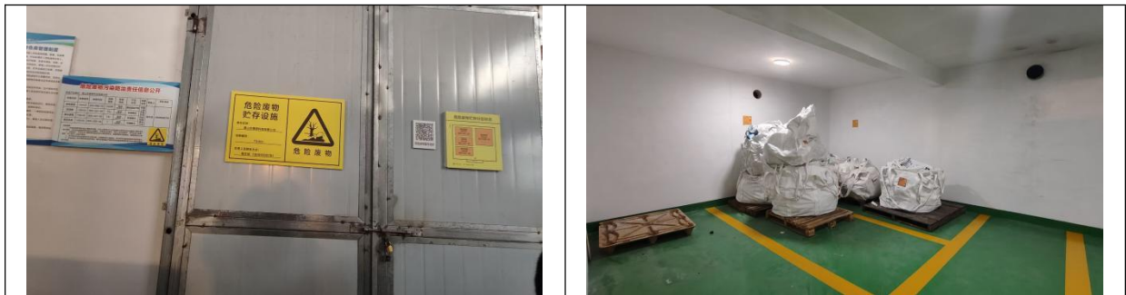
危废暂存间 (TS001)
