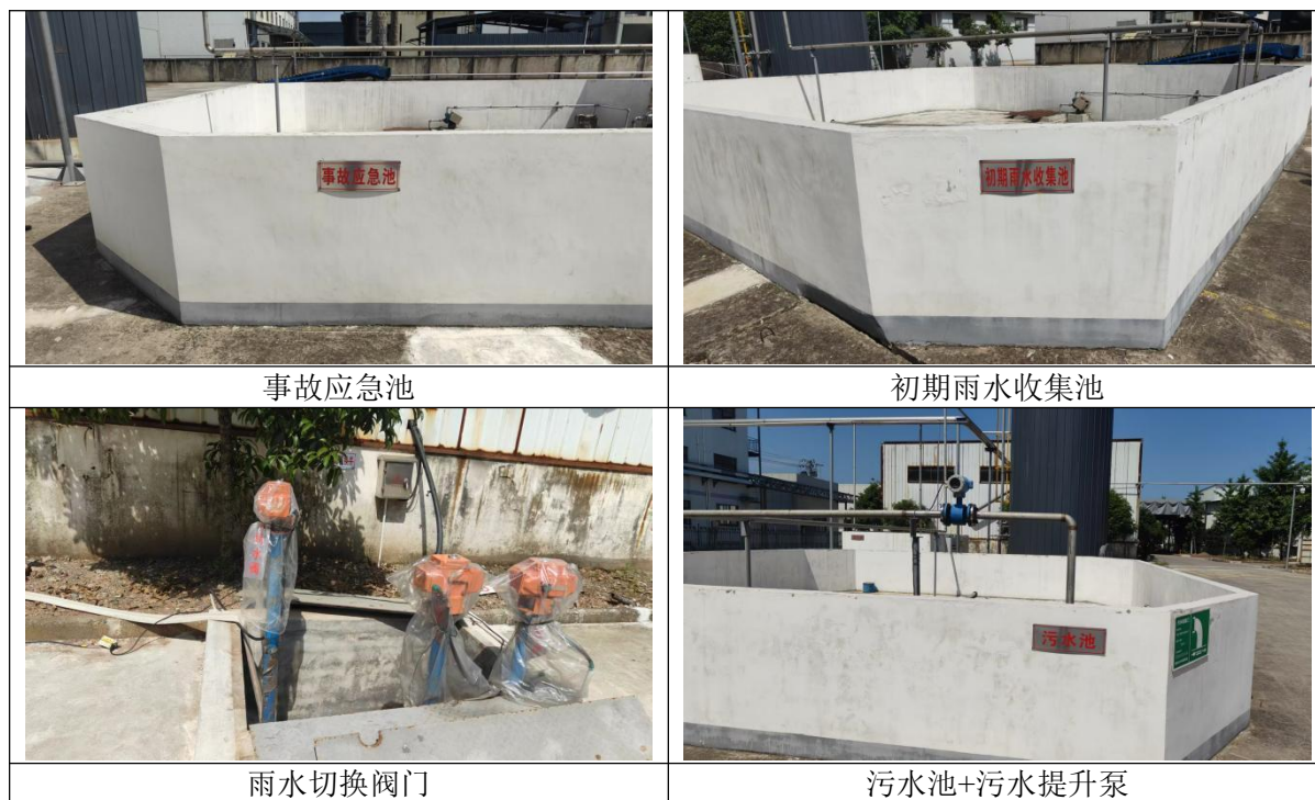
图 4.2-2 事故应急池、初期雨水收集池及阀门
