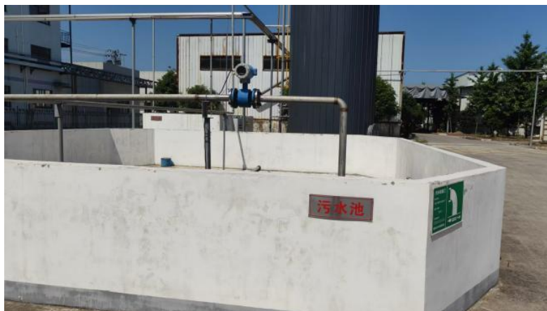
图 4.2-5 厂区污水排放口照片
