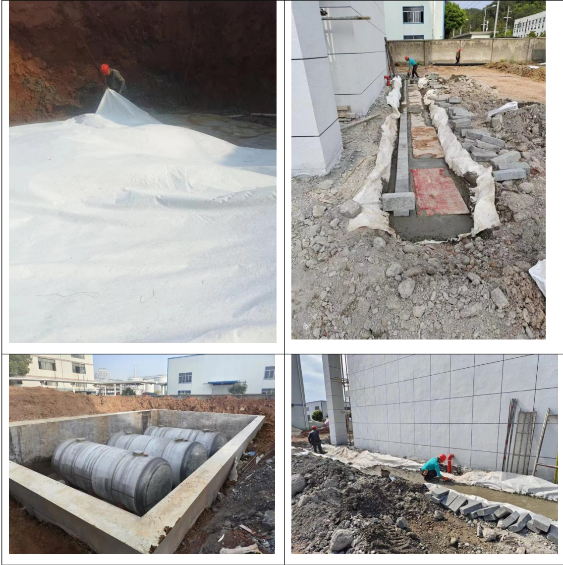
图 4.1-6 防渗施工现场照片
