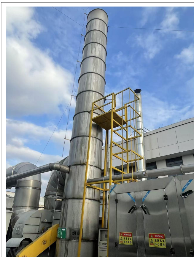
DA001 03-造粒挤出车间造粒废气和挤出车间 2 挤出废气排放口
