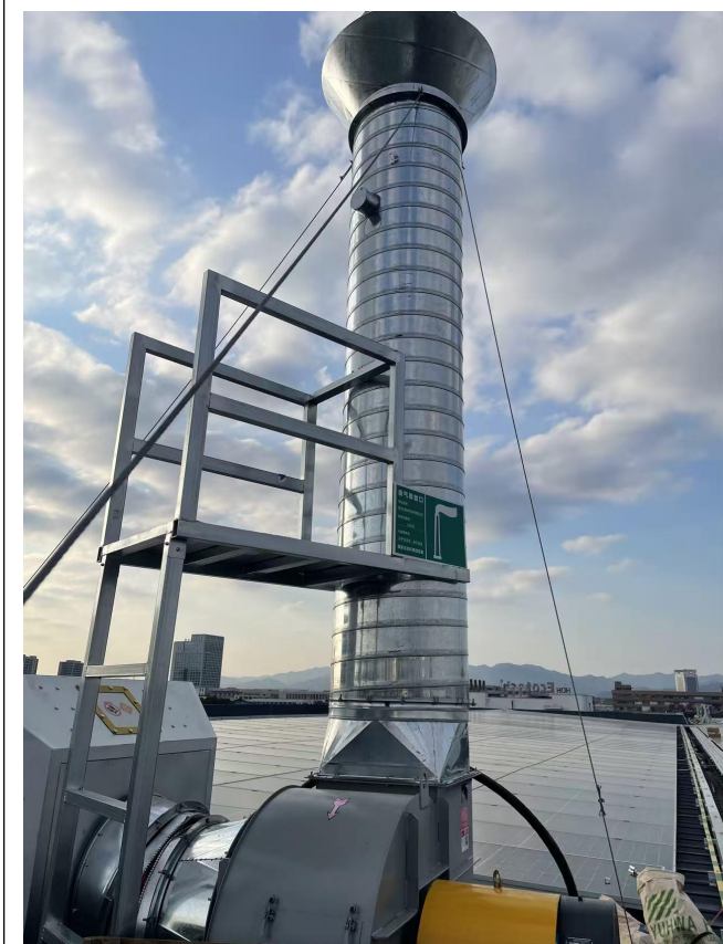
DA001 03-造粒挤出车间造粒废气和挤出车间 2 挤出废气排放口
